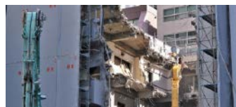
2022年7月 大阪府門真市 解体工事
